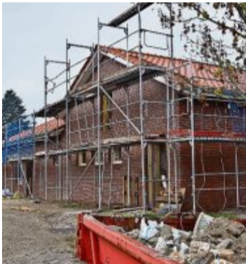
Die Arbeiten gehen voran: Die Baustelle am Feuerwehrhaus in Rhadereistedt. Foto: Hilken
